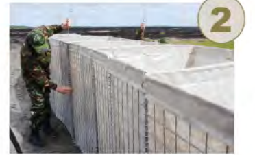
Üniteler, montaj pimleri kullanılarak uzatılır.
