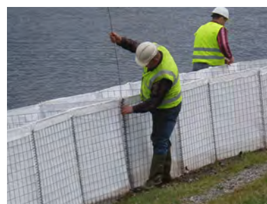
Barrières worden verlengd met verbindingsspennen.
