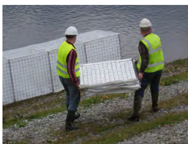
Barrières worden opgebouwd.
