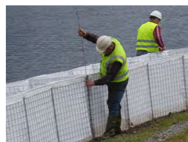
Solidification d'une barrière à l'aide de tiges
