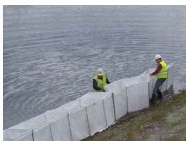
Installation d'une barrière
