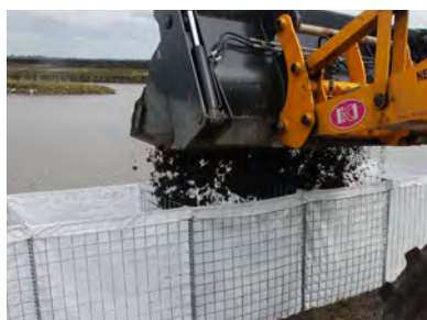
Remplissage d'une barrière Pro-3 avec du sable
